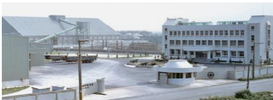
■ 海湖石膏板廠
